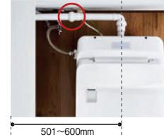
●手洗い設置の壁面から便器中心までの寸法が501~600mmの場合、
