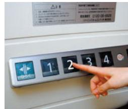
明るく見やすい大型の照光スイッチで、運転状況を表示します。
