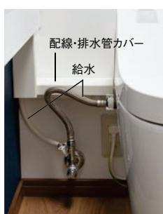
※ 既存の給水管・排水管に商品の給排水を接続したり電気の接続工事は必要です。
