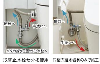
取替止水栓セットを使用 同様の給水器具のみで施工
